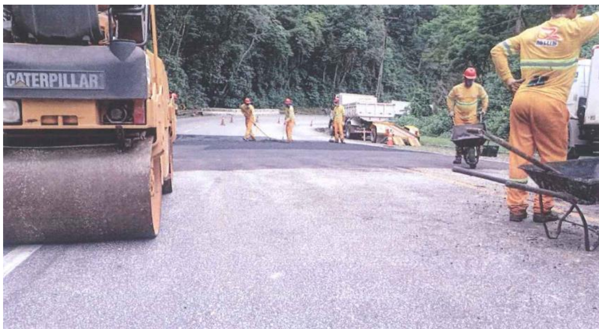
Figura 6.236 Rota 116 – Pavimentação – Km 52+000
