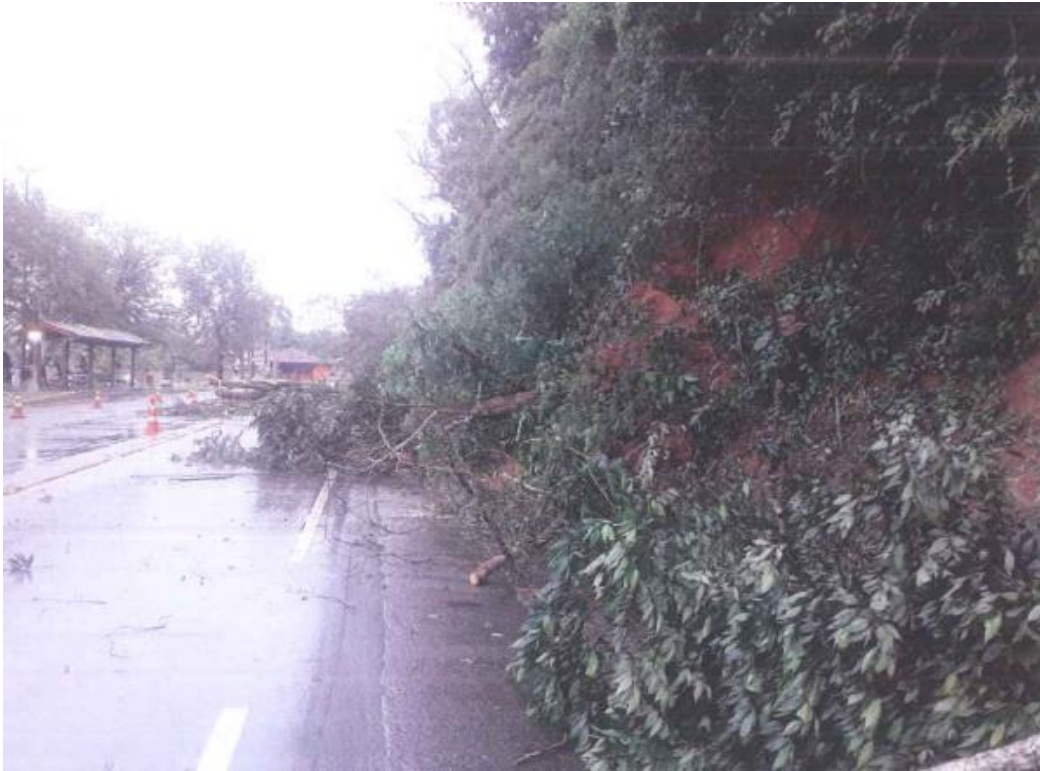
Figura 6.20 Rota 116 – Queda de Barreira – Km 27+900 Norte
