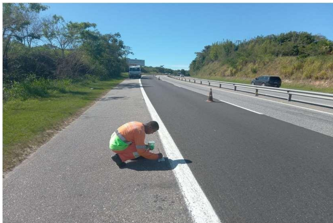
Figura 6.6 Via Lagos – Pintura das Marcas Longitudinais – Km 27+440 Sul
