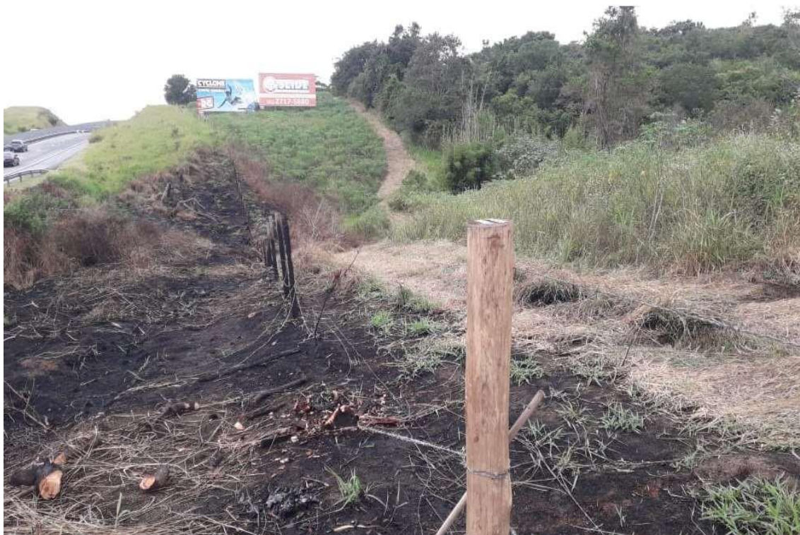
Figura 6.12 Via Lagos – Recuperação de Cercas – Km 40+600 Norte [1]
