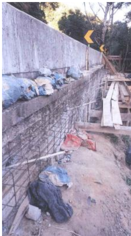
Figura 6.23 Rota 116 – Reforço no muro de contenção – Km 56+600 Sul
