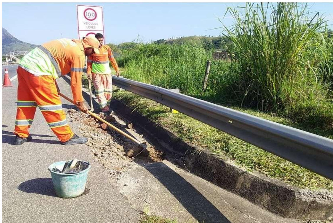
Figura 6.10 Via Lagos – Recuperação de Sarjeta – Km 12+500 Sul
