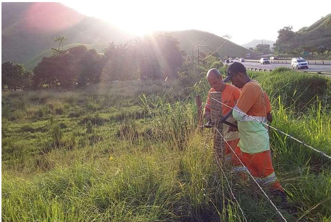
Figura 6.14 Via Lagos – Recuperação de Cercas – Km 8+200 Norte
