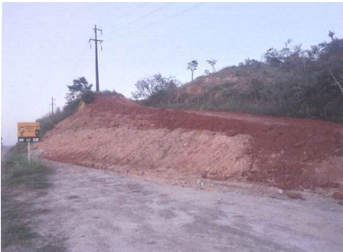
Figura 6.19 Rota 116 – Recomposição de Talude – Km 2+800 Norte
