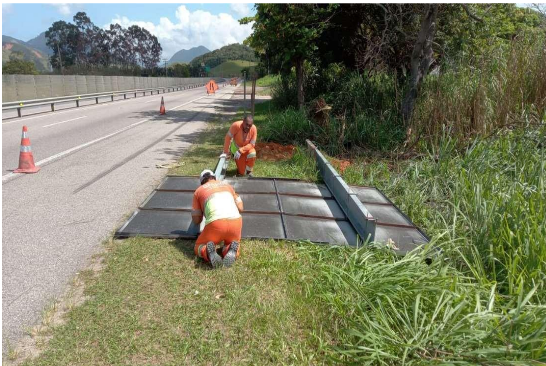
Figura 6.2 Via Lagos – Manutenção da Sinalização Vertical – Km 23+500 Sul [1]
