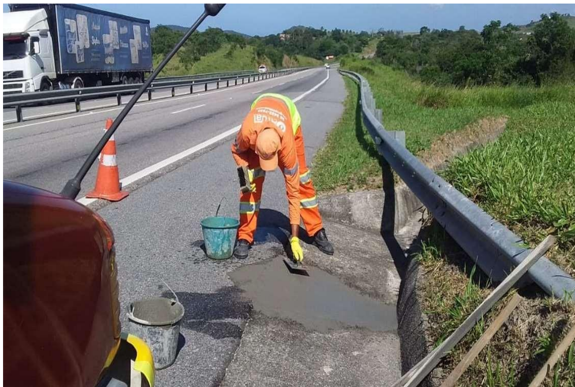
Figura 6.9 Via Lagos – Recuperação de Sarjeta – Km 48+800 Sul
