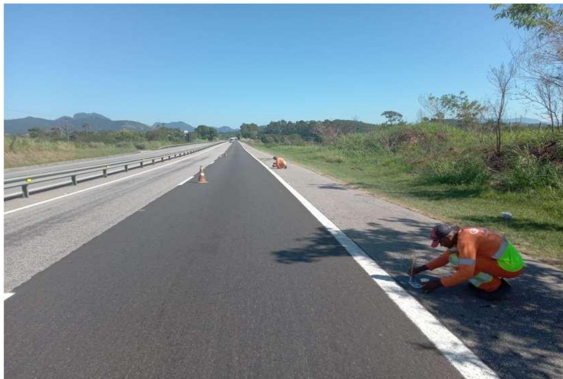
Figura 6.5 Via Lagos – Pintura das Marcas Longitudinais – Km 32+740 Sul
