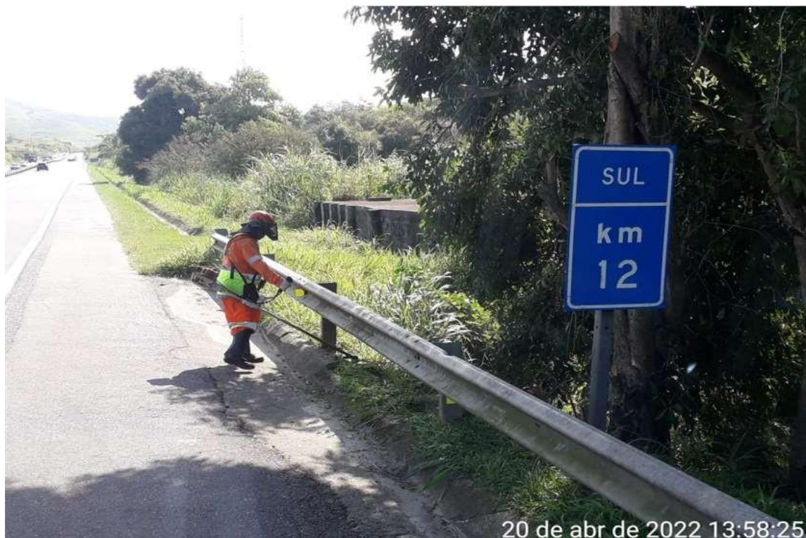
Figura 6.16 Via Lagos – Roçada Manual – Km 12+000 Sul
