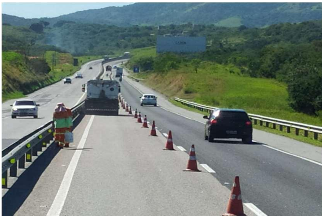
Figura 6.18 Via Lagos – Varrição Mecânica – Km 54+000 Norte
