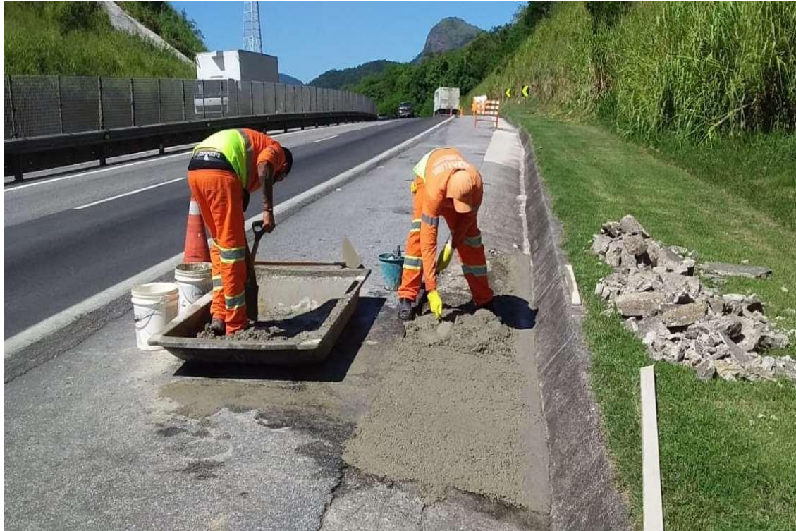
Figura 6.11 Via Lagos – Recuperação de Sarjeta – Km 5+000 Norte
