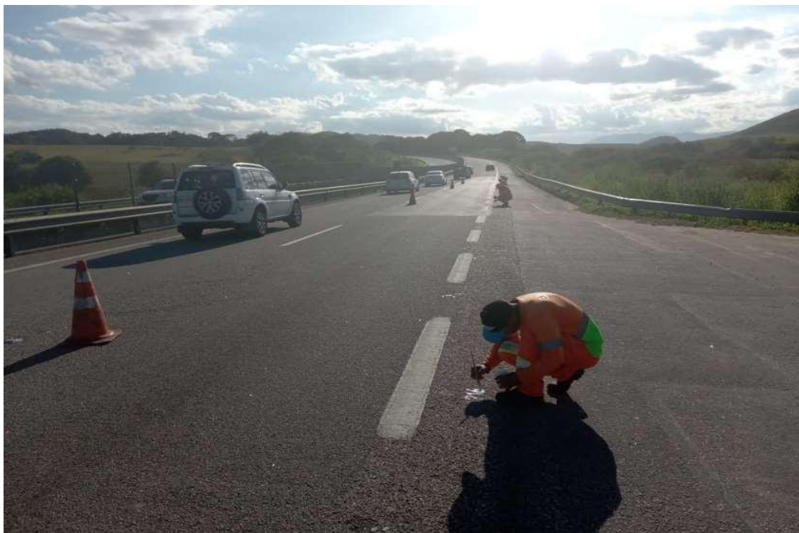
Figura 6.4 Via Lagos – Pintura das Marcas Longitudinais – Km 24+000 Sul
