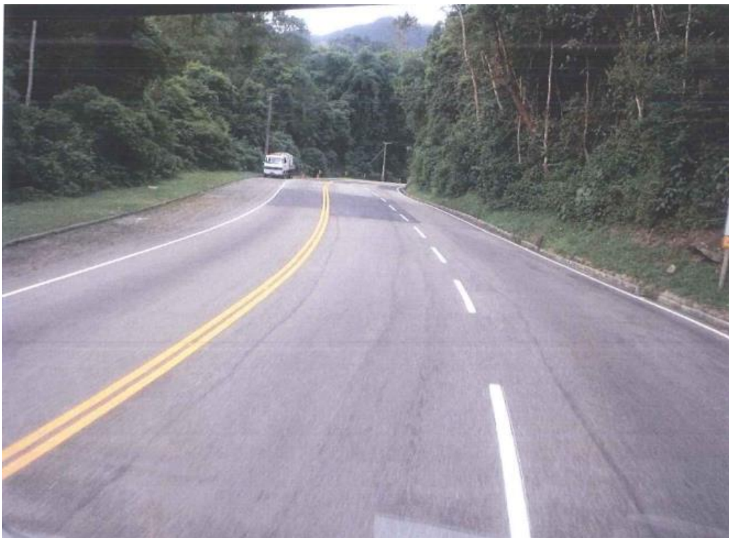
Figura 6.21 Rota 116 – Manutenção da Sinalização Horizontal – Km 56+500
