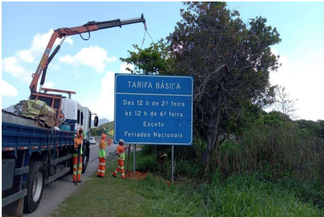
Figura 6.3 Via Lagos – Manutenção da Sinalização Vertical – Km 23+500 Sul [2]
