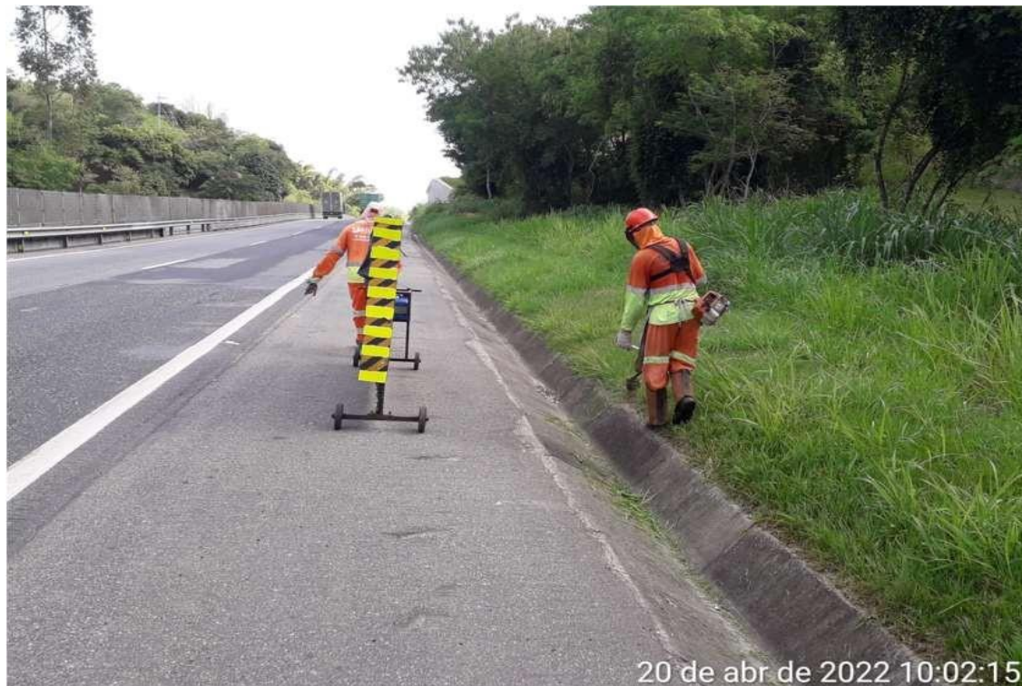
Figura 6.15 Via Lagos – Roçada Manual – Km 15+900 Sul
