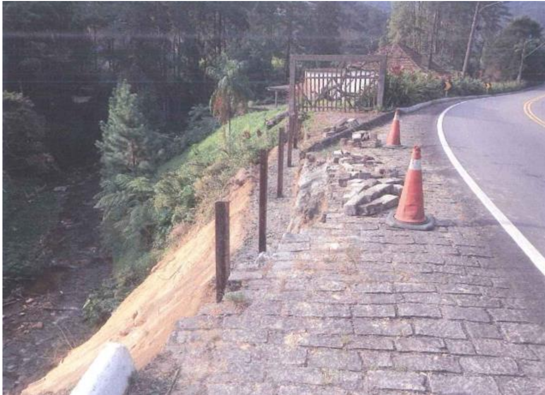
Figura 6.22 Rota 116 – Obra emergencial de contenção – Km 67+800 Sul
