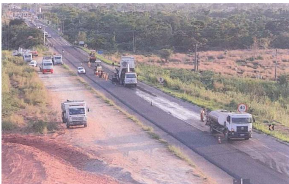
Figura 6.25 Rota 116 – Pavimentação – Km 0+000 – 3+500
