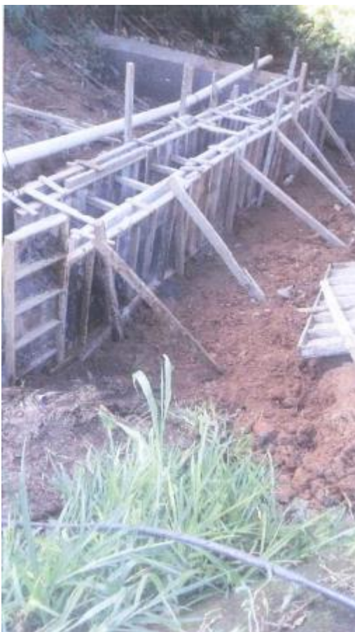
Figura 6.24 Rota 116 – Ampliação sistemas de drenagem – Km 117+000 Sul
