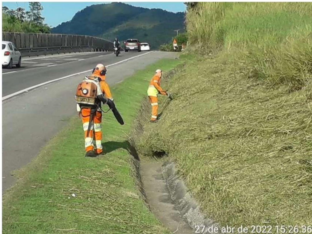
Figura 6.17 Via Lagos – Roçada Manual – Km 9+900 Norte
